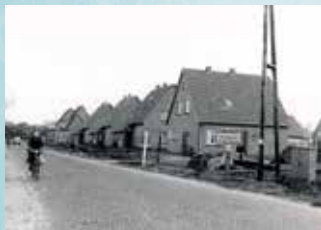
Alte Ortseinfahrt Blumenstraße Ecke Schepser Damm, 60er
