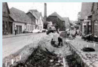
Bau der Schmutzwasserkanalisation, Hauptstraße, Ende 60er
