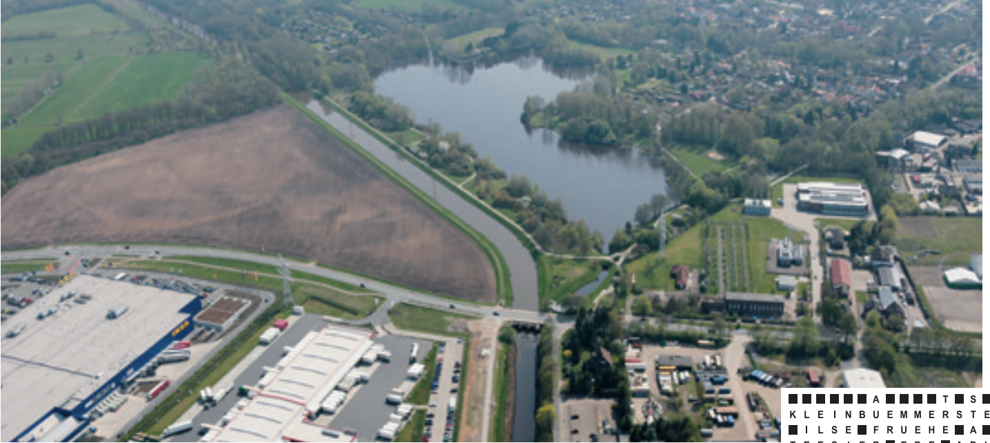
Der Mündungsbereich des Hemmelbäker Kanals.
