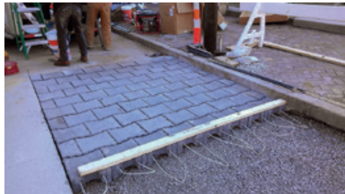
Versickerungsfähiges Pflaster. Hiermit wird der Boden nicht versiegelt. Regenwasser kann trotz der Pflasterung im Boden versickern und durch Verdunstung (Hitze) wieder aufsteigen. Quelle: USEPA Environmental-Protection-Agency
