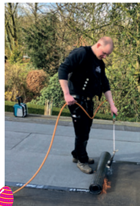
Adrian Jessen beim Arbeiten auf einem Flachdach Quelle: Adrian Jessen
